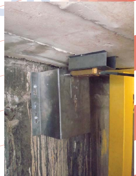
Instalación de extensómetros ópticos.
